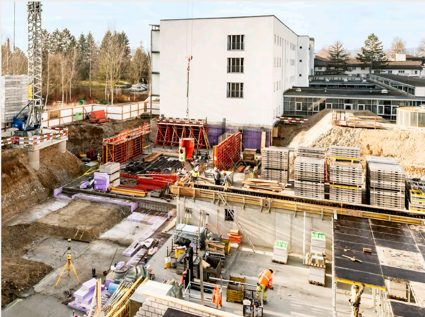
Baustelle des Erweiterungsbaus «Reha Ost» (Dezember 2016)
